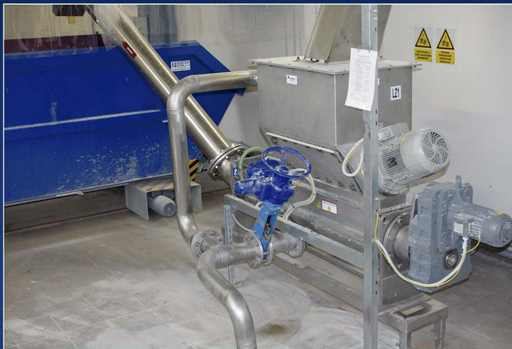
Inštalácia závitkového lisu s praním zhrabkov z hrablic TE-SKJH
