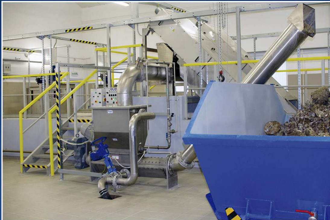
Inštalácia závitovkového lisu s praním zhrabkov z hrabíc TE-SKJH
