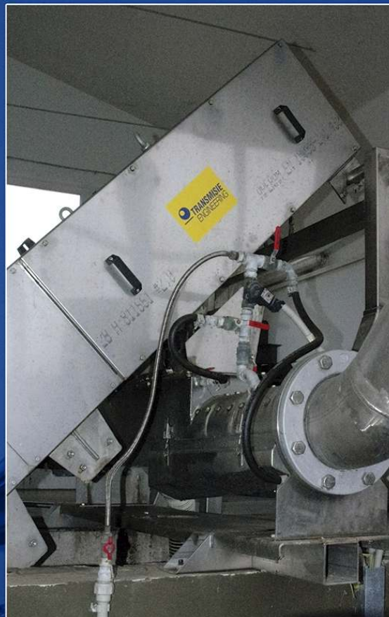
Inštalácia jemných schodíkových hrabčíc TE-SKJH so závitovkovým lisom
