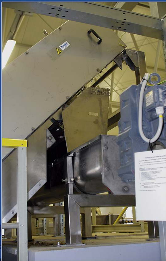
Inštalácia jemných schodíkových hrabčíc TE-SKJH so závitovkovým dopravníkom
