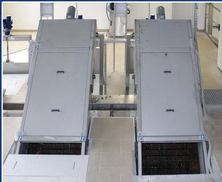
Inštalácia jemných schodíkových hrabíc TE-SKJH s dopravníkom na zhrabky
